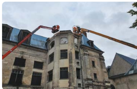
Travaux de dépollution et démolition sur le site de Villers-Cotterêts, France
