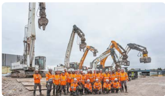
Chantier EPC Demosten, France
