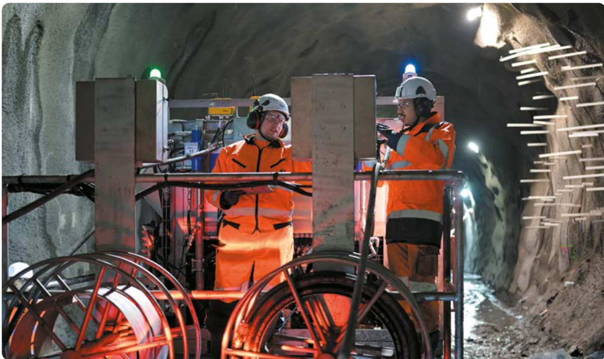
Chantier du TELT, France
