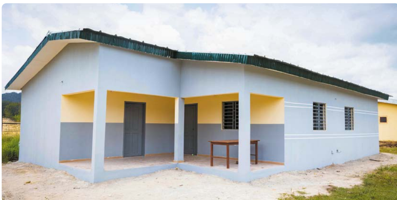
Construction d'une maison pour des enseignants par EPC Côte d'Ivoire
